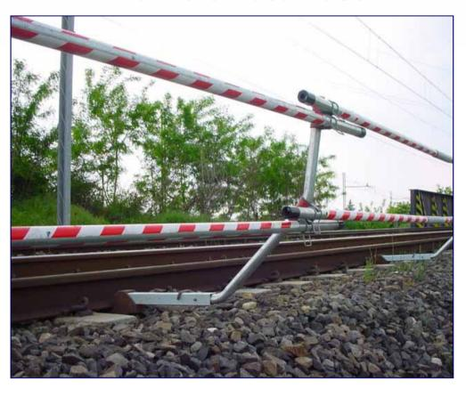
Il loro uso è previsto per cantieri fissi e di durata medio/lunga (Cantieri fissi operanti in area adiacente al binario in esercizio, come per esempio cantieri di opere civili, quali rifacimento marciapiedi, lavori di contenimento, etc). Non compatibili con i cantieri mobili dell'armamento (rinnovo binario).
